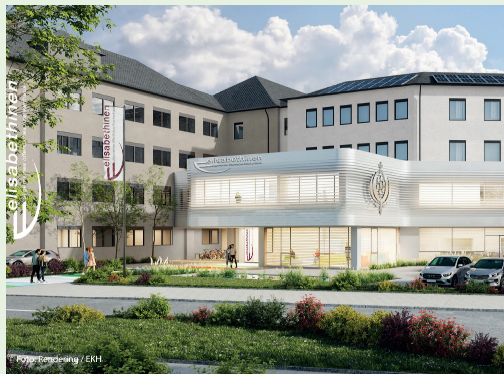
Die Pläne sehen einen großzügig überdachten bedarfsgerechten Hauptzugang vor, mit definiertem Wartebereich im Erdgeschoss. Die Zukunft ist ein mit Tageslicht erhellter Postnarkose-Bereich.
