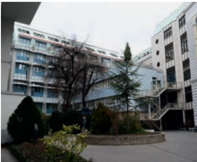
Links: die geschwungene Balkonfassade des Neubaus
