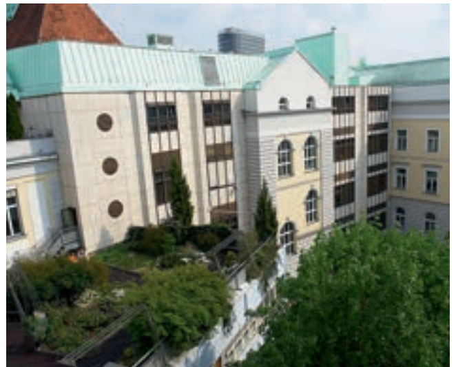
Der Dachgarten über der Onkologischen Tagesklinik
