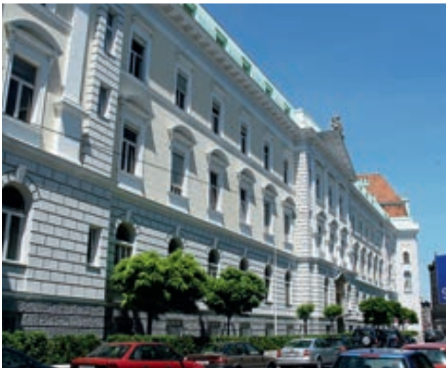
Der alte Krankenhausblock wurde vollkommen renoviert und aufgestockt.
