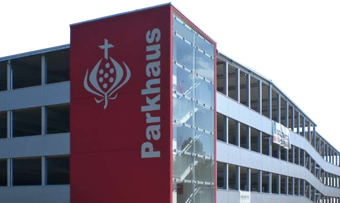
Ansicht des neuen Parkdecks
